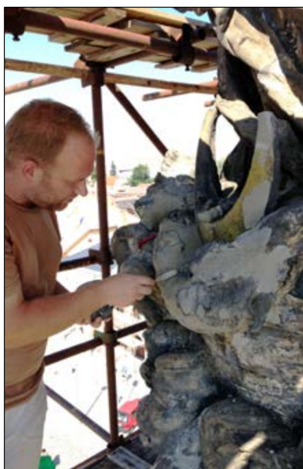
P. Gláser při tmelení sochařské výzdoby na mrovém sloupu v Poličce.
