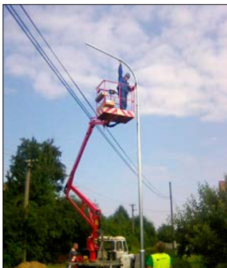
Nové veřejné osvětlení. Jedna z řady inves- tičních akcí, které dokážou zajistit pracovní- ci z Místního hospodářství vlastními silami kompletně. „Co vše se nechá s partou dobrých pracovníků vymyslet a zrealizovat, jsem si ani já nemyslel a vždy jsem byl mile překvapen. Z toho, co jsme s touto partou dokázali, mám velikou radost,“ říká jejich končící nadřízený.
