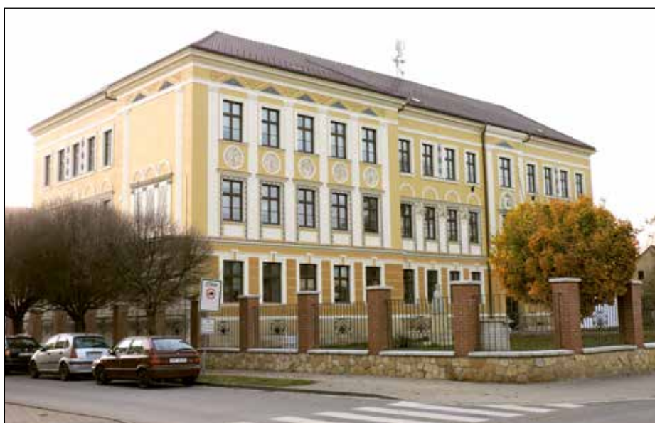
Čerstvě obnovená fasáda v roce 2021.
