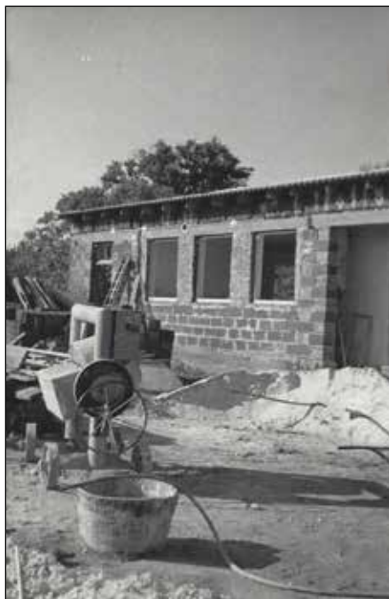
Výstavba školní dílny.
