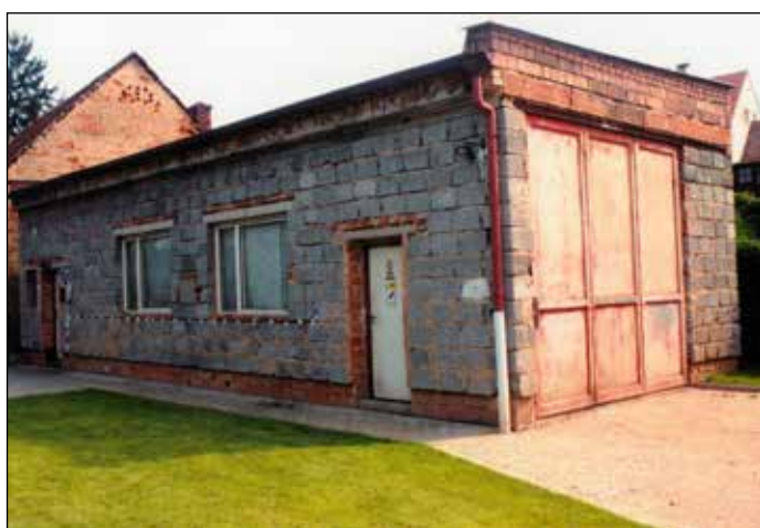
Výstavba třetí garáže staré zbrojnice.
