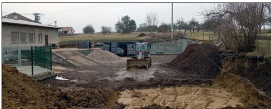
Práce na budoucím sběrném dvoře.
