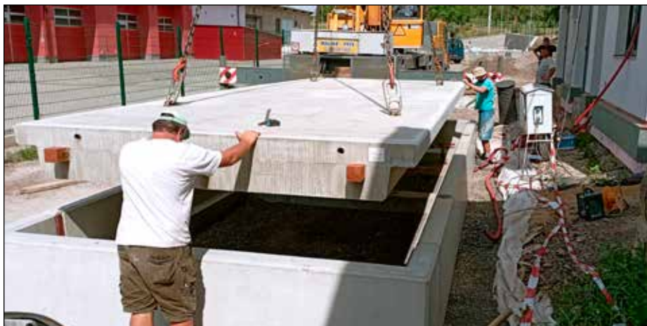
Práce na sběrném dvoře ve finiši.
