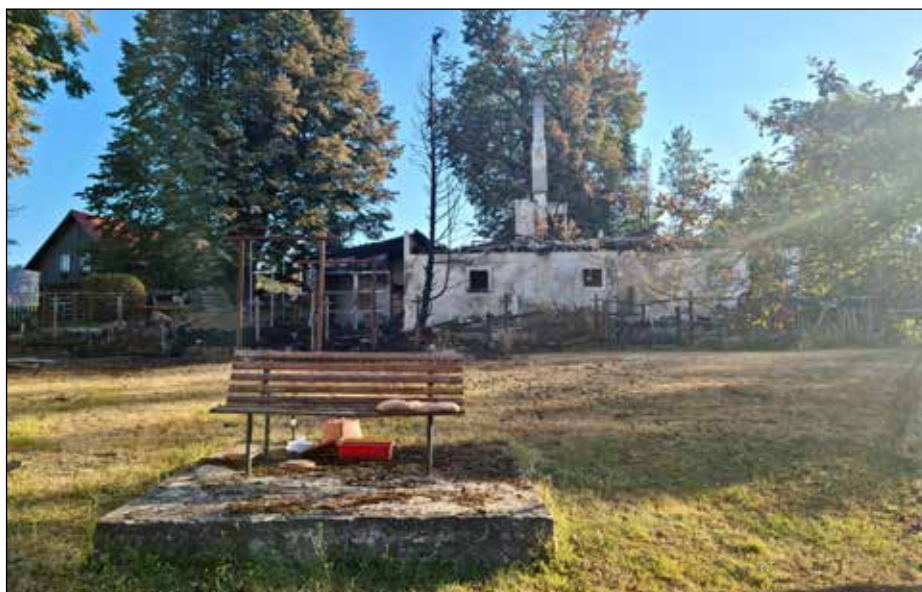
Pohled z našeho ubytování: jeden ze tří domů zasažených požárem v obci Mezná.
