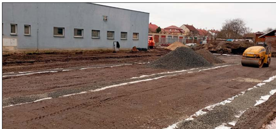
Stavba hřiště u školy po zimě pokračuje.
