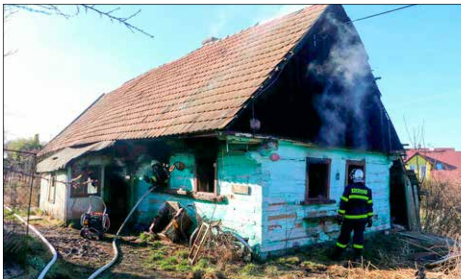
16. 3. 2023 / Nemyčeves / Požár rodinného domu
