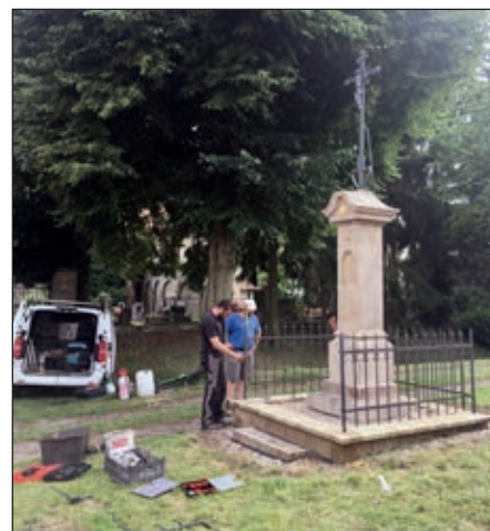
Kovář a restaurátor osazují obnovené kovové oplocení kolem opraveného kříže, červenec 2022.
