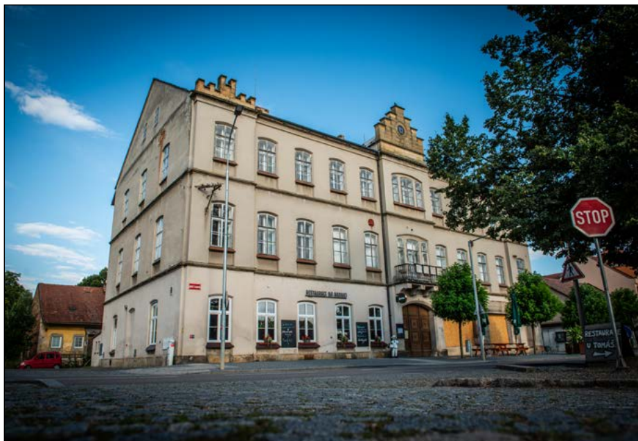
Na kompletní rekonstrukci bývalá radnice ještě čeká. V přízemí už ale vzniká bistro.
