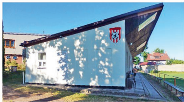
Započatá rekonstrukce fasády.
