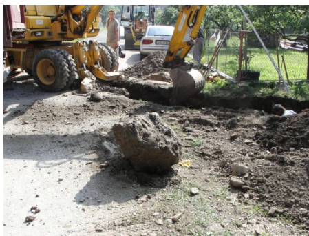
Při výkopu nebyla nouze o velké kameny (přípojka u Obstů)
