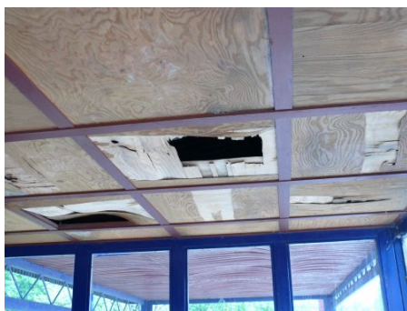
Strop autobusové zastávky u konzumu
