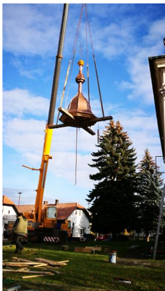
Osazování nového sanktusníku na střechu kostela sv. Bartoloměje
