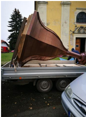
Osazování nového sanktusníku na střechu kostela sv. Bartoloměje
