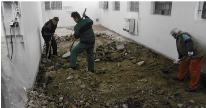
2xfoto: Práce v hasičárně 2019 - archiv SDH
