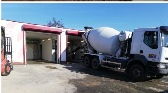
4xfoto: Práce v hasičárně 2019 - archiv SDH
