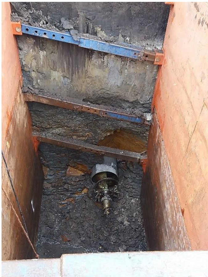
2xfoto: Výstavba kanalizace – archiv obce
