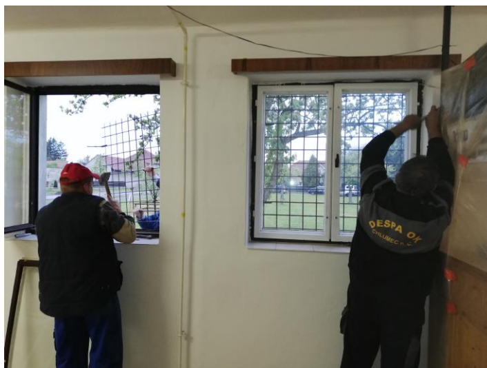
Foto: Výměna oken na hasičárně - archiv SDH
