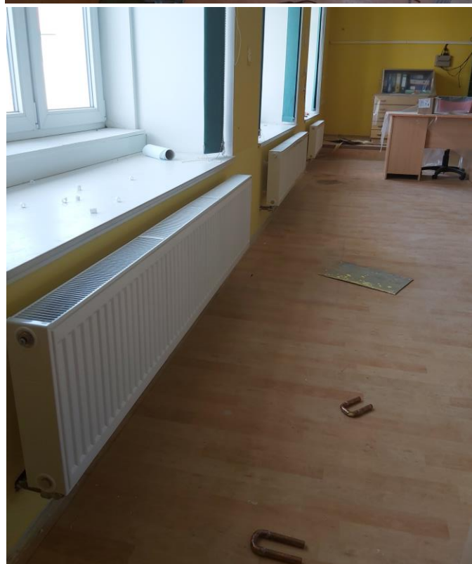
3x foto: Instalace radiátorů – archiv obce
