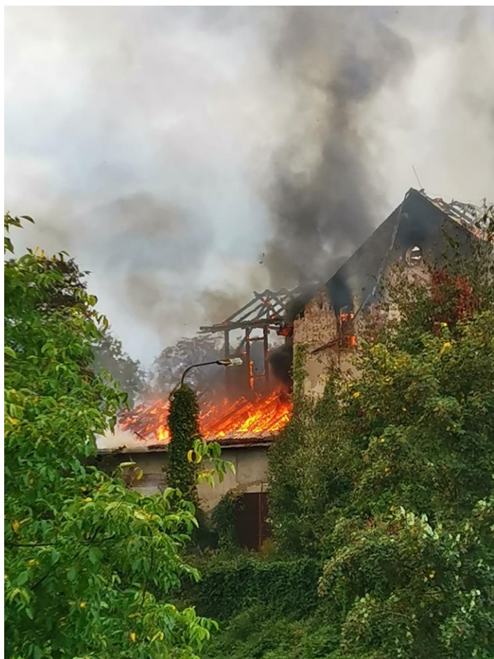
4x foto: 12. 09. Chlumec n. C. – požár několika budov - archiv SDH
