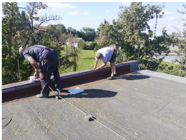
Foto: Natírání střechy hasičárny 25. 9. 2021 - archiv SDH
