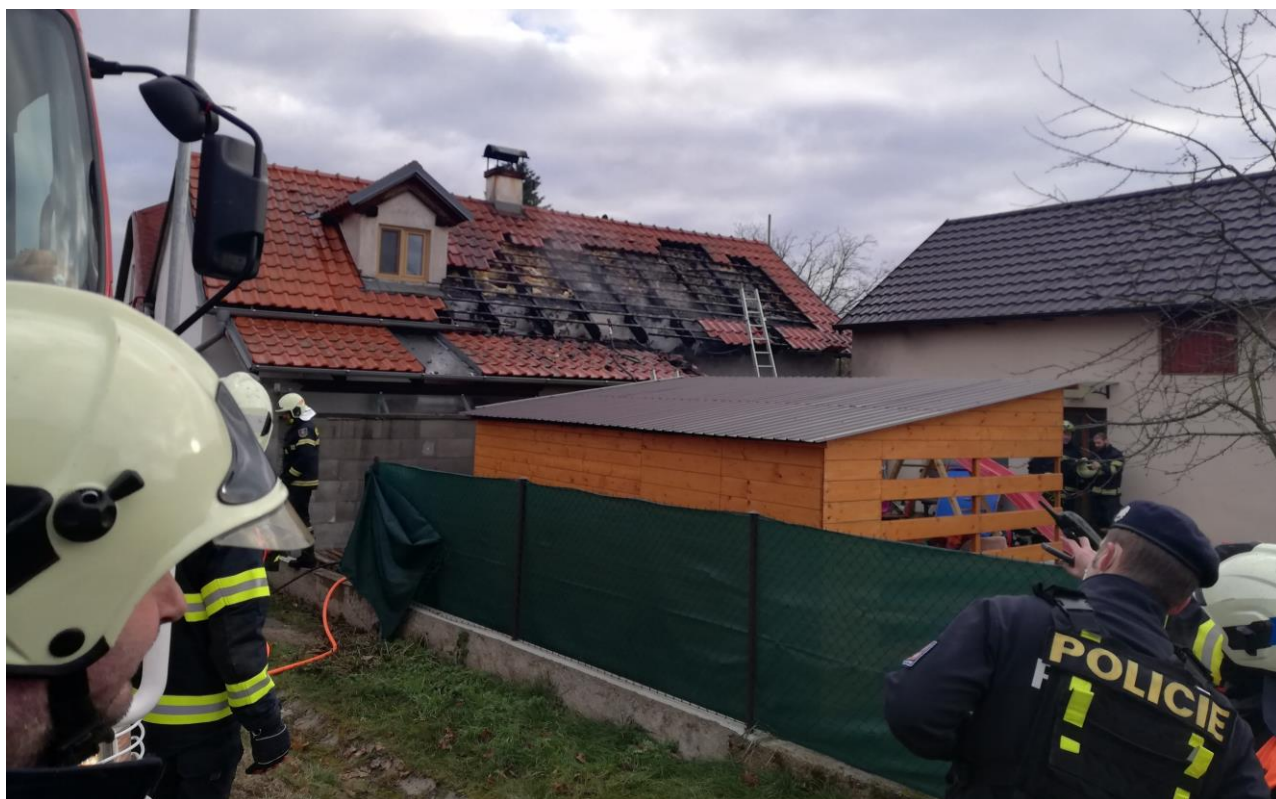
Foto: Požár Chlumec n. C. – střecha rodinného domu 8. 1. 2022 - archiv SDH
