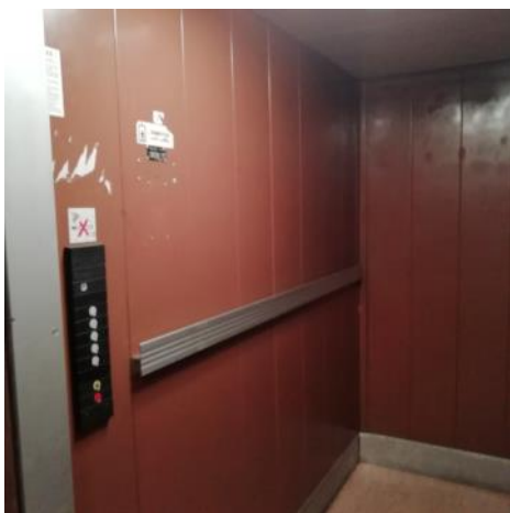
Výtah v čp. 421 před rekonstrukcí....
