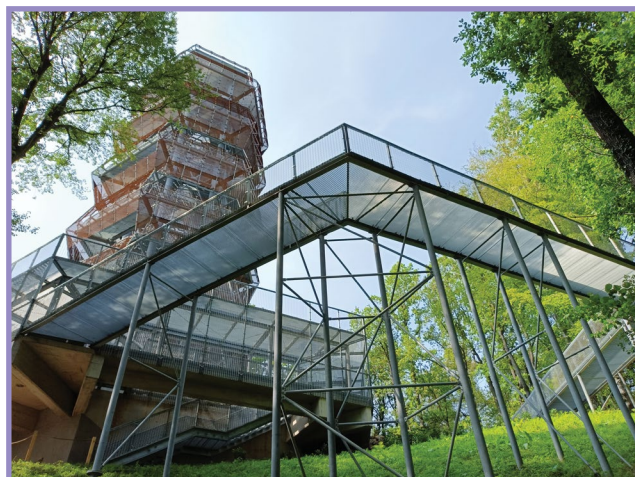
Valbřich - obvodový můstek u rozhledny
