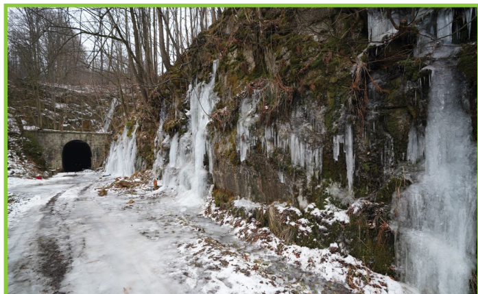
vchod do tunelu
