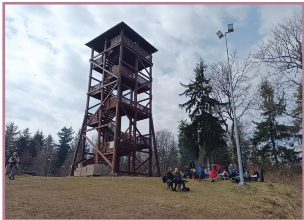
U horní stanice lanovky
