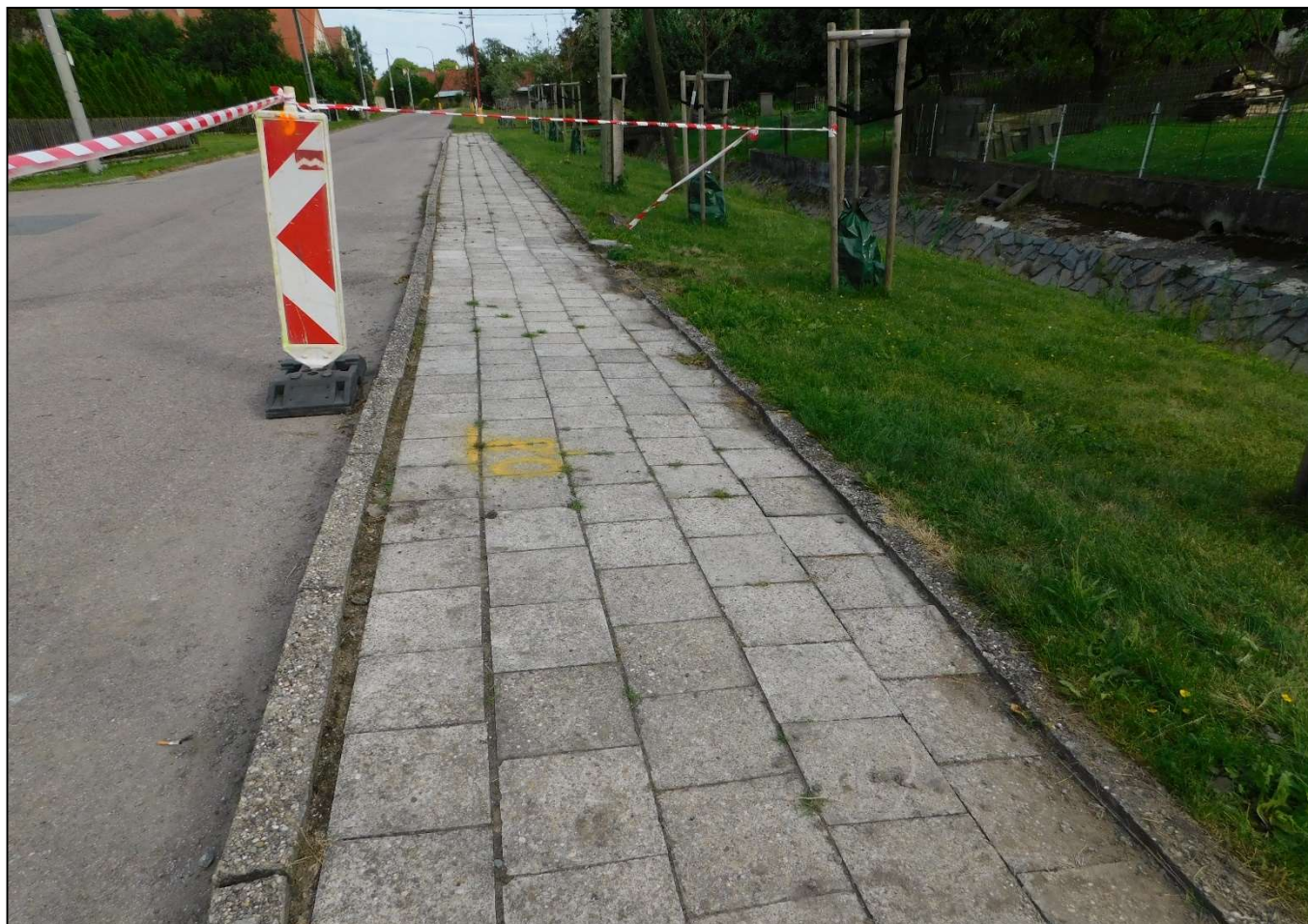
Poslední fotografie zastávky, úřední desky a chodníků před opravou fotografovala 22. 6. 2022 Dagmar Honsnejmanová
