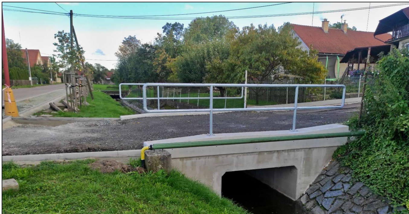
Nový propustek se zábradlím – fotografoval Jiří Franc
