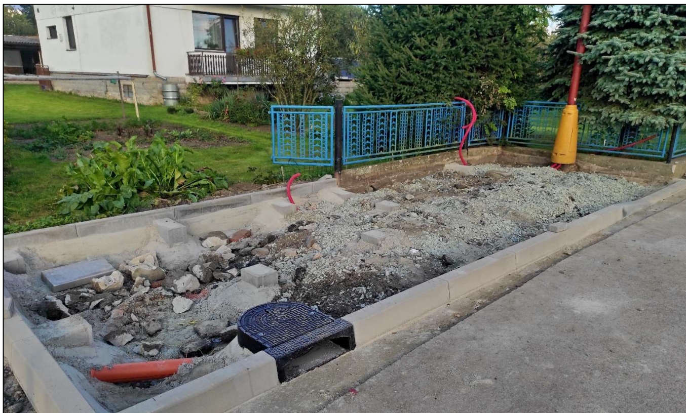
Práce na chodníku na zastávce autobusu – fotografoval Jiří Franc
