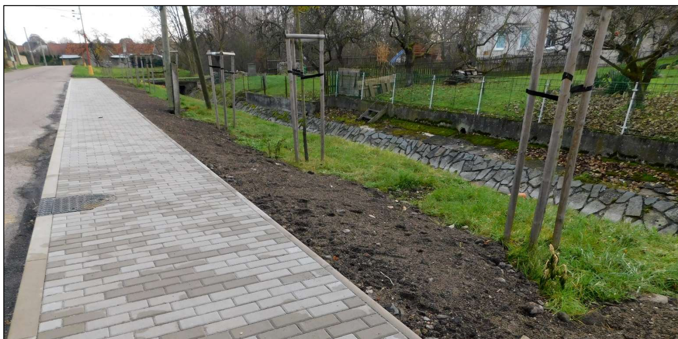
Opravený chodník u bytovek
