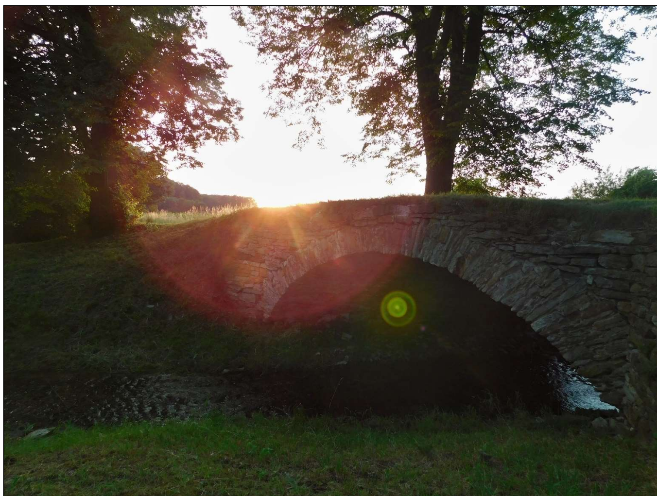
Zapadající slunce u kamenného mostu
