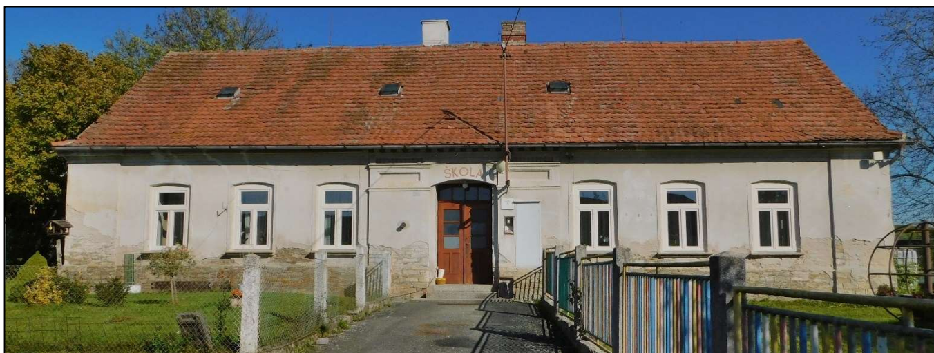
Nová plastová okna v bývalé škole čp. 20
