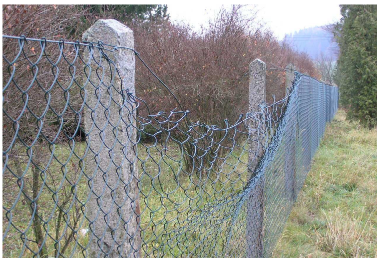
Poškozený plot na urnovém háji.
