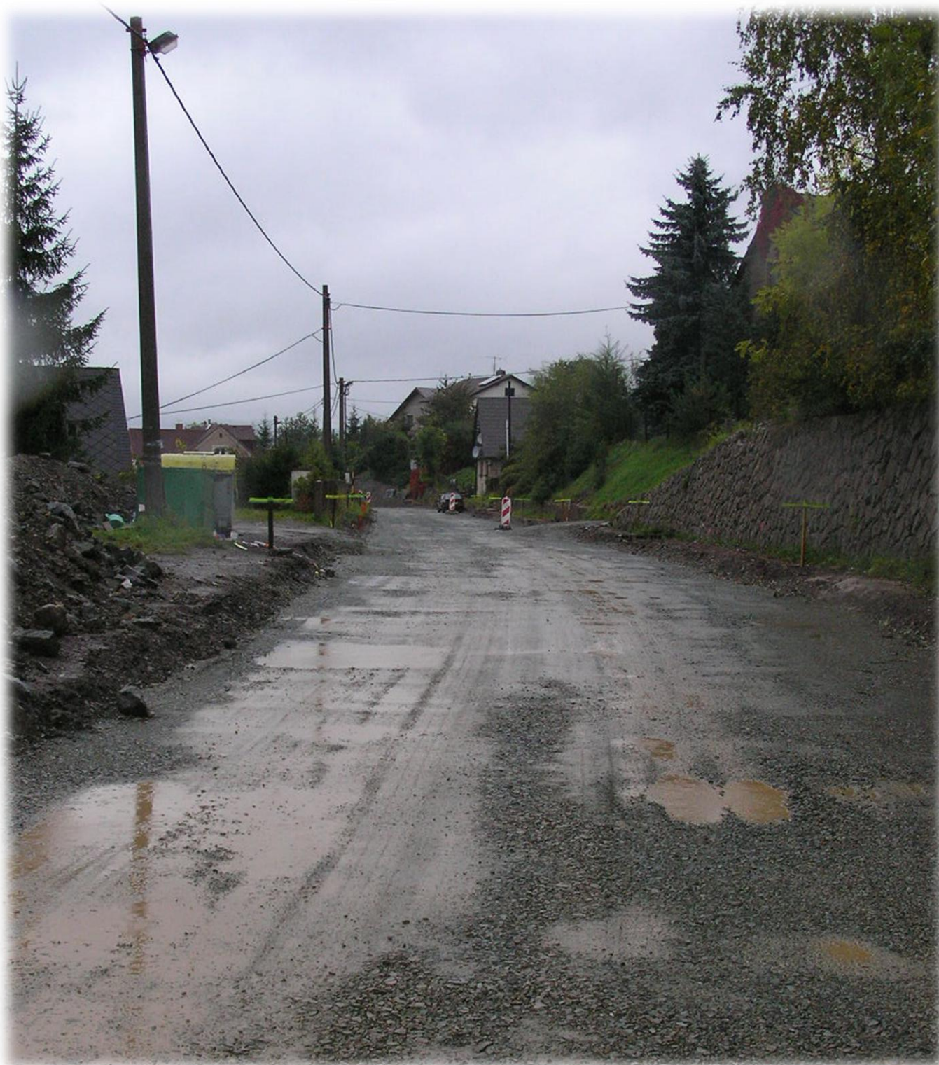
Rekonstrukce ulice Hronovská
