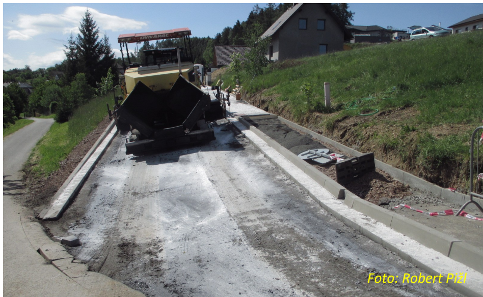
Příprava pro pokládku nového asfaltového povrchu v ulici Pod Strání.
