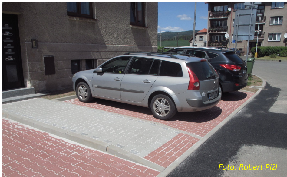
Dokončení oprav chodníků a parkovacích ploch v ulici Hornická čp. 643.
