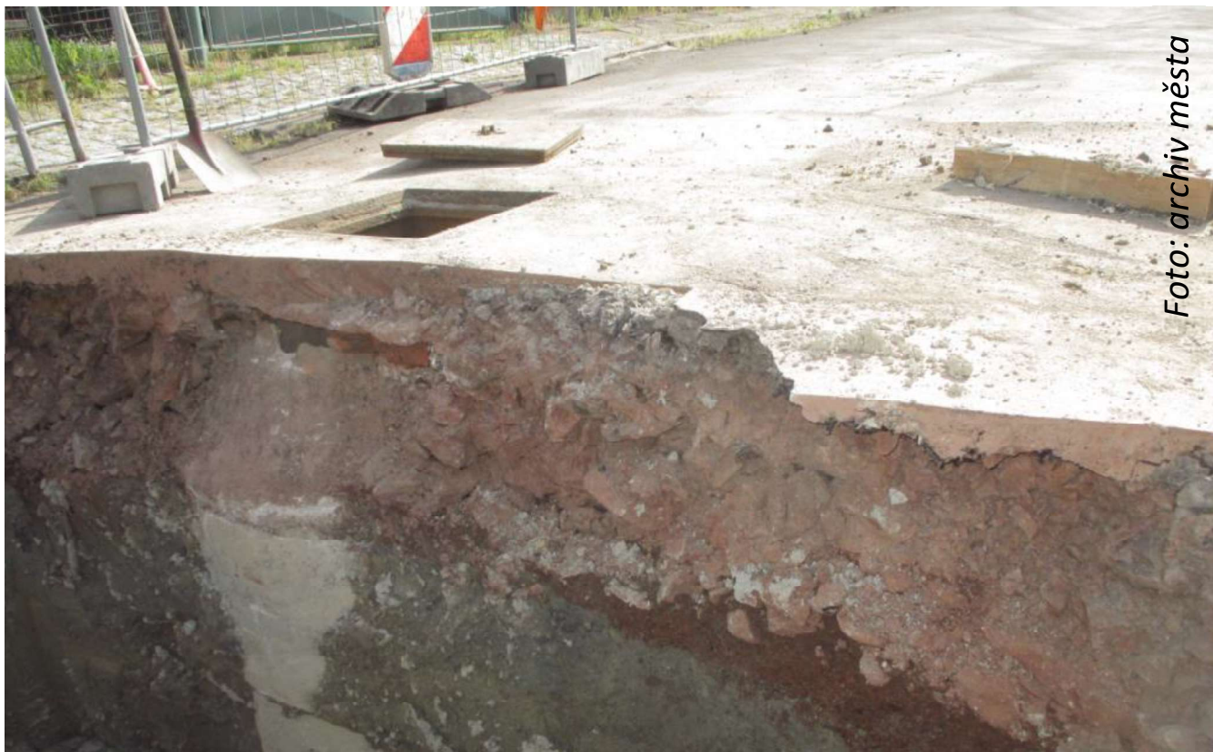
Začátkem června byla zahájena oprava kanalizace v ulici Sadová.
