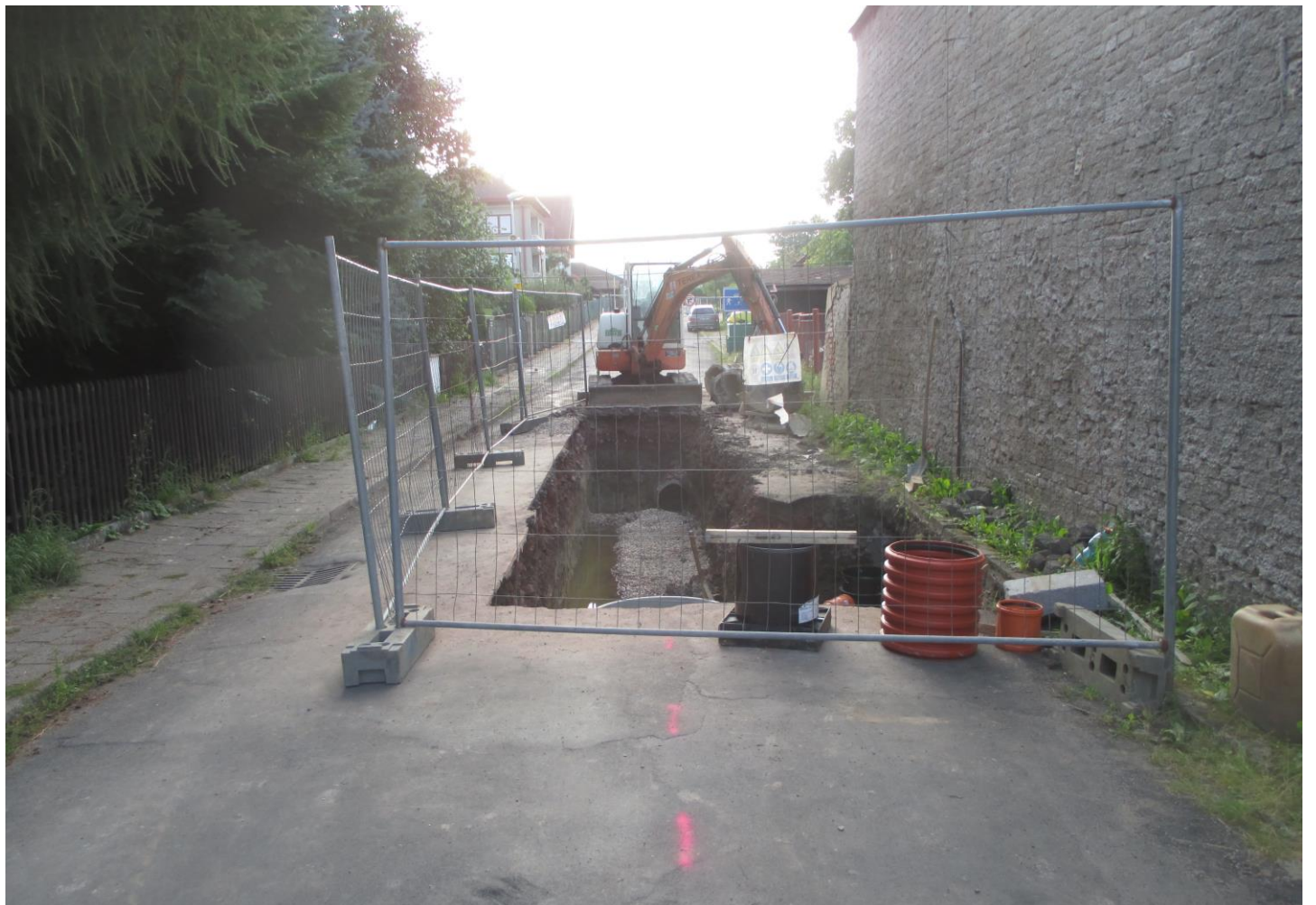
Oprava kanalizace Rychetského a Sadová (3x fotoarchiv města)
