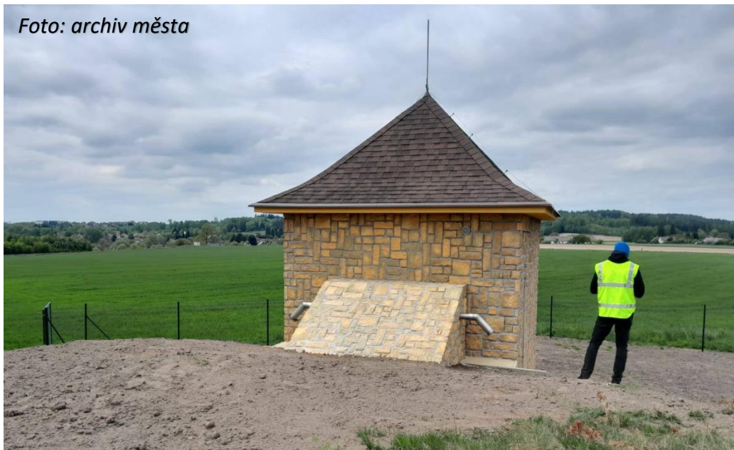
Oprava vodojemu na Brodkách je dokončena.
