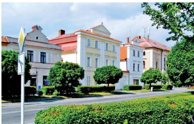
Původní stav před zahájením prací.
