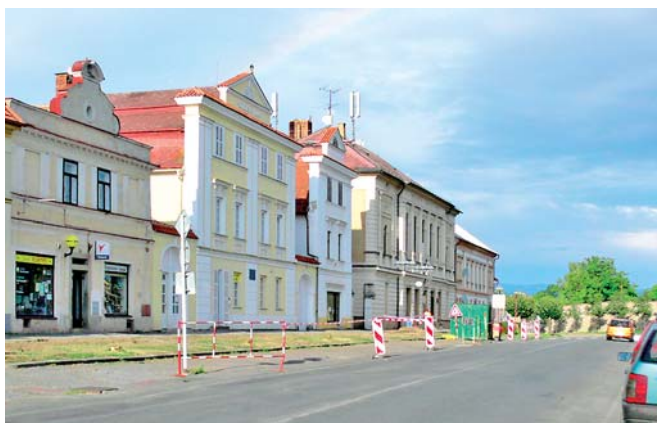
Stav krátce po zahájení prací, 4. září 2008.
