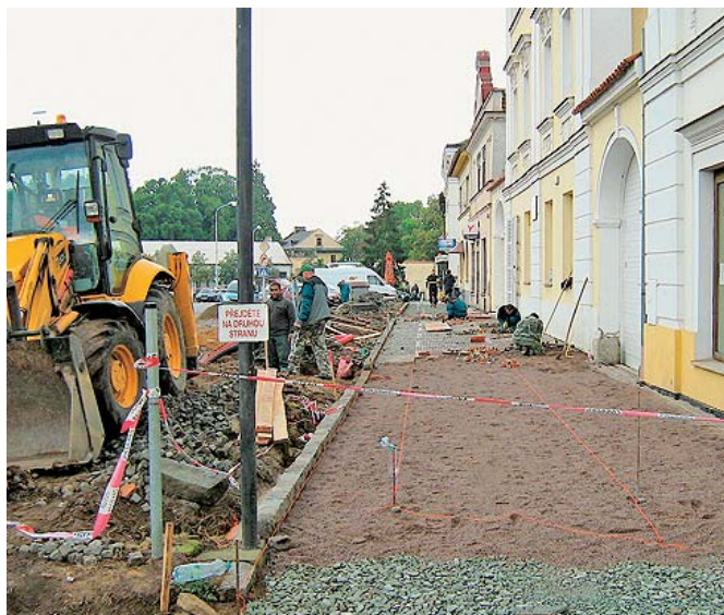
Úpravy chodníku a parkovacích ploch
