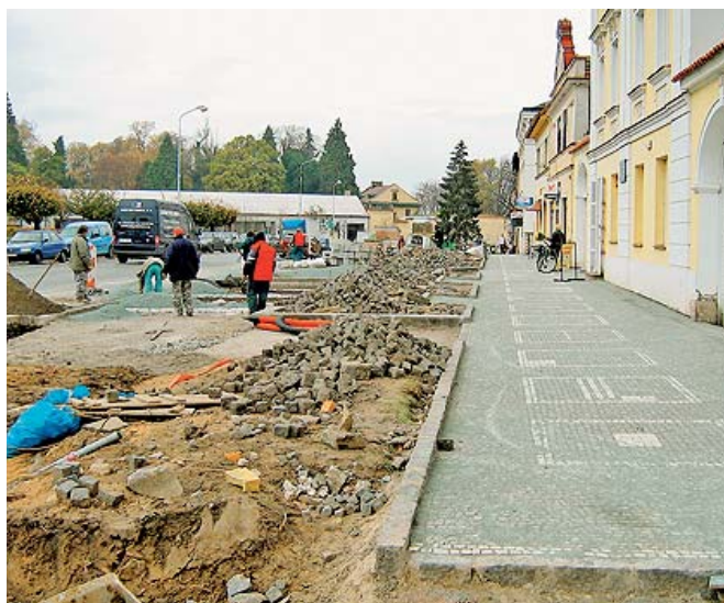
Úpravy chodníku a parkovacích ploch
