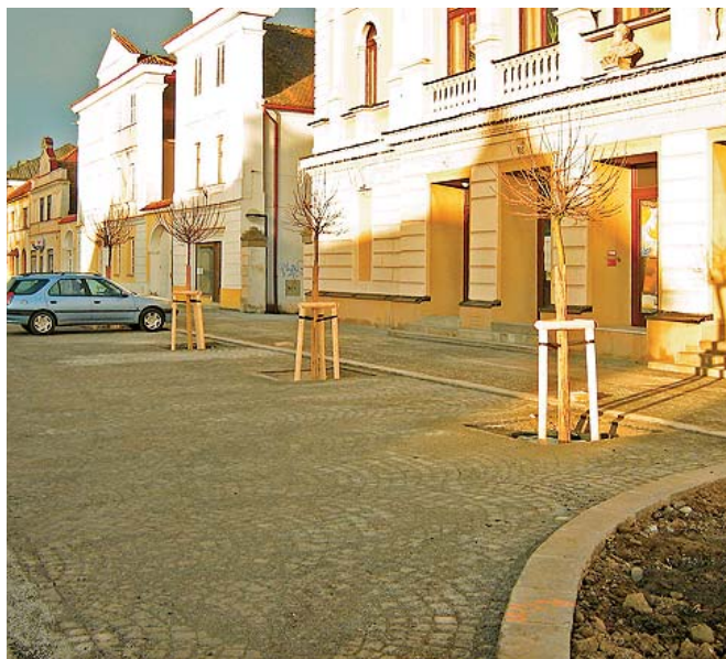
Stav po dokončení první etapy
