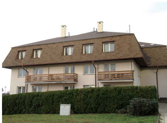
Po dvaceti letech se dům s pečovatelskou službou může pochlubit novou střechou a opravenými balkóny. foto: archiv MěÚ Opočno
