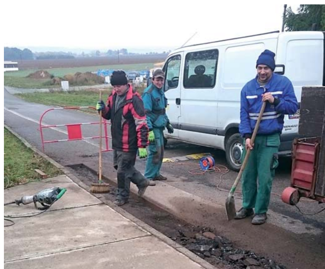
Pohořská ulice – příprava pro asfaltování. foto: 2x archiv TSMO
