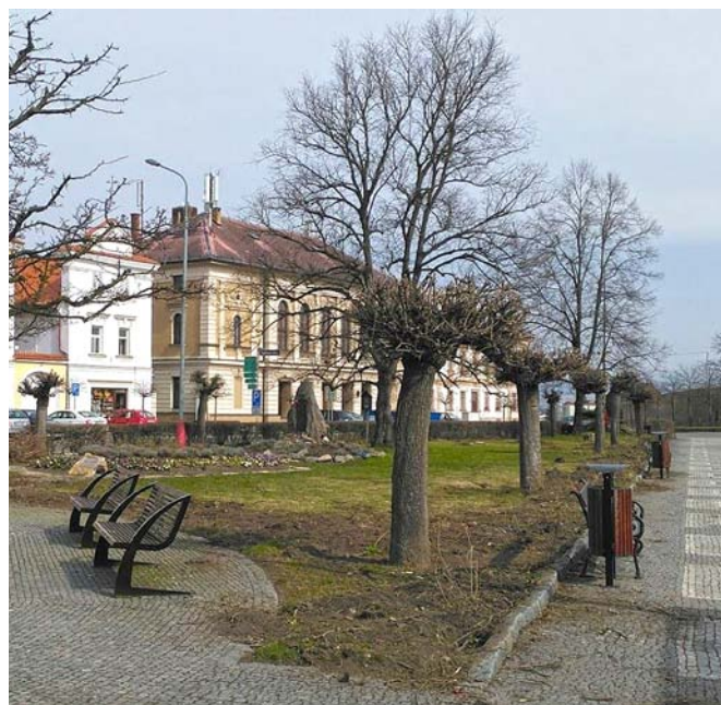
První práce proběhly v druhé polovině března. Byly odstraněny keřové porosty ze strany náměstí směřující ke klášteru. foto: red
