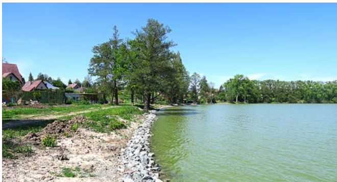
Nově zpevněný břeh ještě před doplněním stromové výsadby. foto: red
