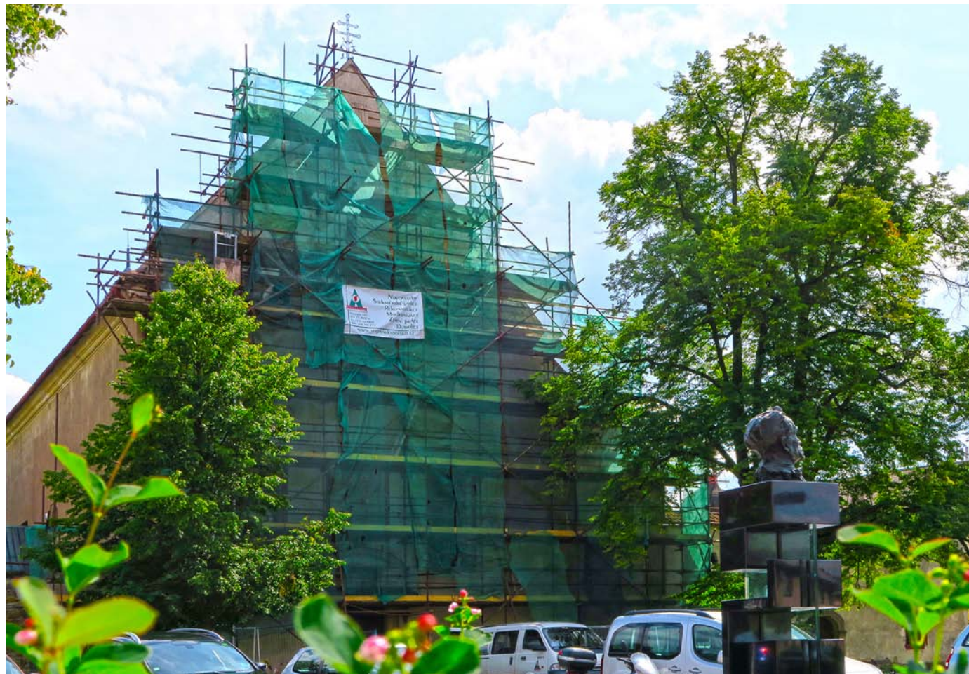
Náklady na opravu fasády klášterního kostela přesáhnou jeden milion korun. Hotovo by mělo být do letošního listopadu. foto: (red)
