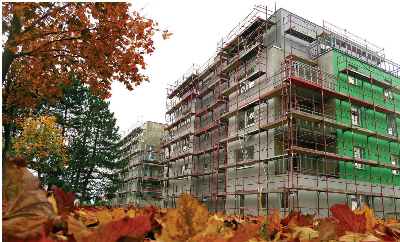
Rozestavěné domy v Severním sektoru. První dva z nich by měly být zkolaudovány letos v prosinci.
