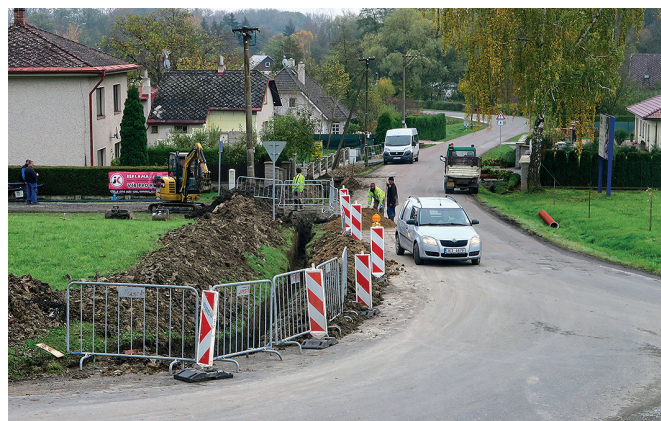
Práce na vodovodu v ulici U Broumaru.
