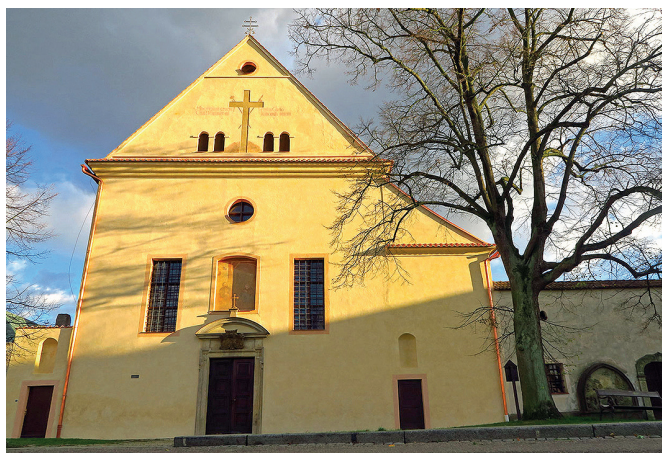
Barevnost fasády kostela vychází z autentických nálezů a rekonstruována byla s použitím kvalitní ručně připravované vápenné barvy. foto: 2x red
