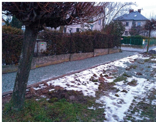
Oprava chodníku v Nádražní ulici.
