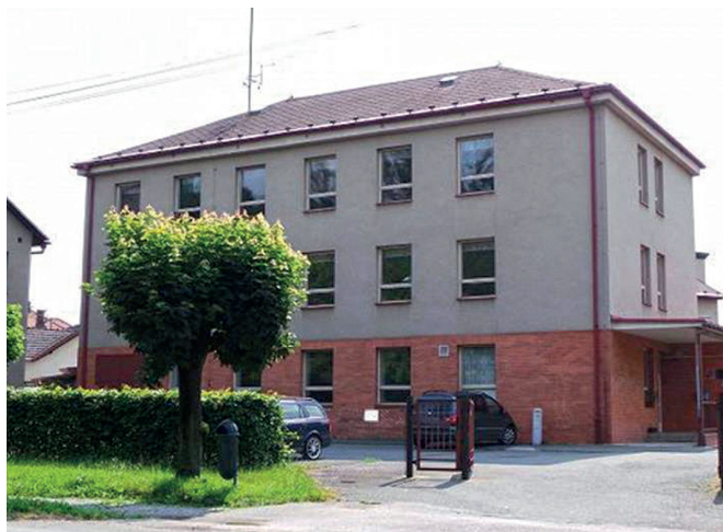
Budova základní školy v Opočenské ulici.
