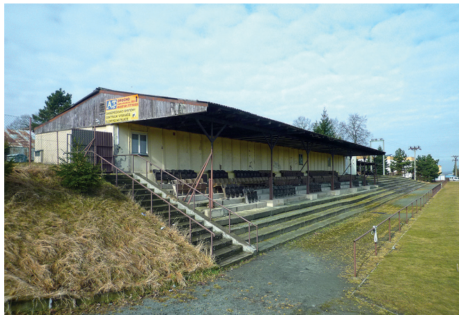
Letitá ubytovna u fotbalového stadionu.
