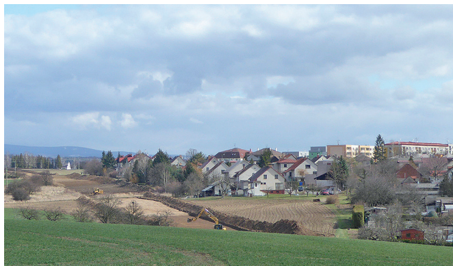
Práce na obchvatu probíhají také ze směru od Jordánku.
