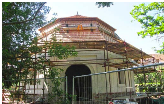
Pokládka nové šindelové střechy.
