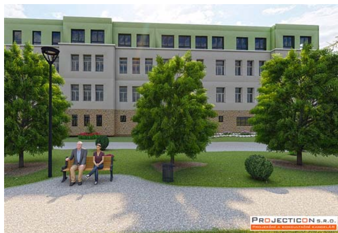
Stavební práce budou trvat 19 měsíců a hotovo by mělo být v první polovině roku 2022.
