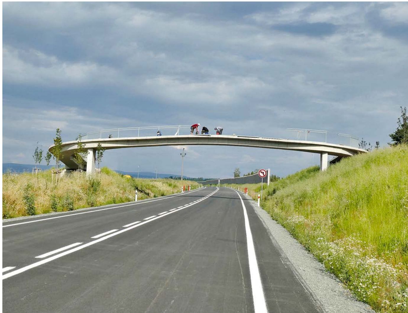
Stavba I. etapy obchvatu Opočna finišuje. Z lávky přes komunikaci bude krásný výhled na Orlické hory.
