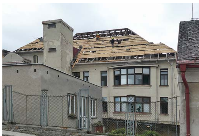
Střecha jde dolů (21. 9. 2020)
