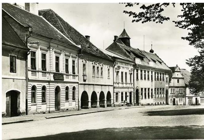
Mezi domy na Trčkově náměstí si zaslouží pozornost dům čp. 8, bývalý Okresní sirotčinec. Sloužil od roku 1908 asi pro třicet dětí. zdroj: Archiv letopisecké komise v Opočně.
