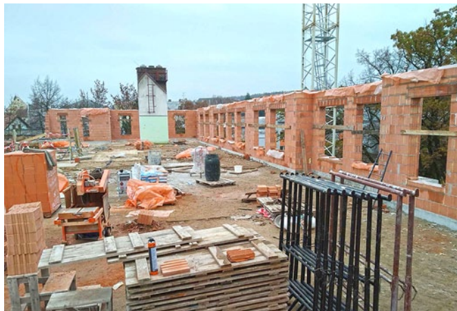
Probíhající práce na budově bývalé chirurgie, kde vzniká dům pro seniory. foto: 5x archiv města
