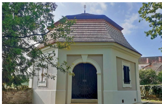
Kostnice u Mariánského kostelíku prošla kompletní rekonstrukcí. foto: archiv města Opočna
